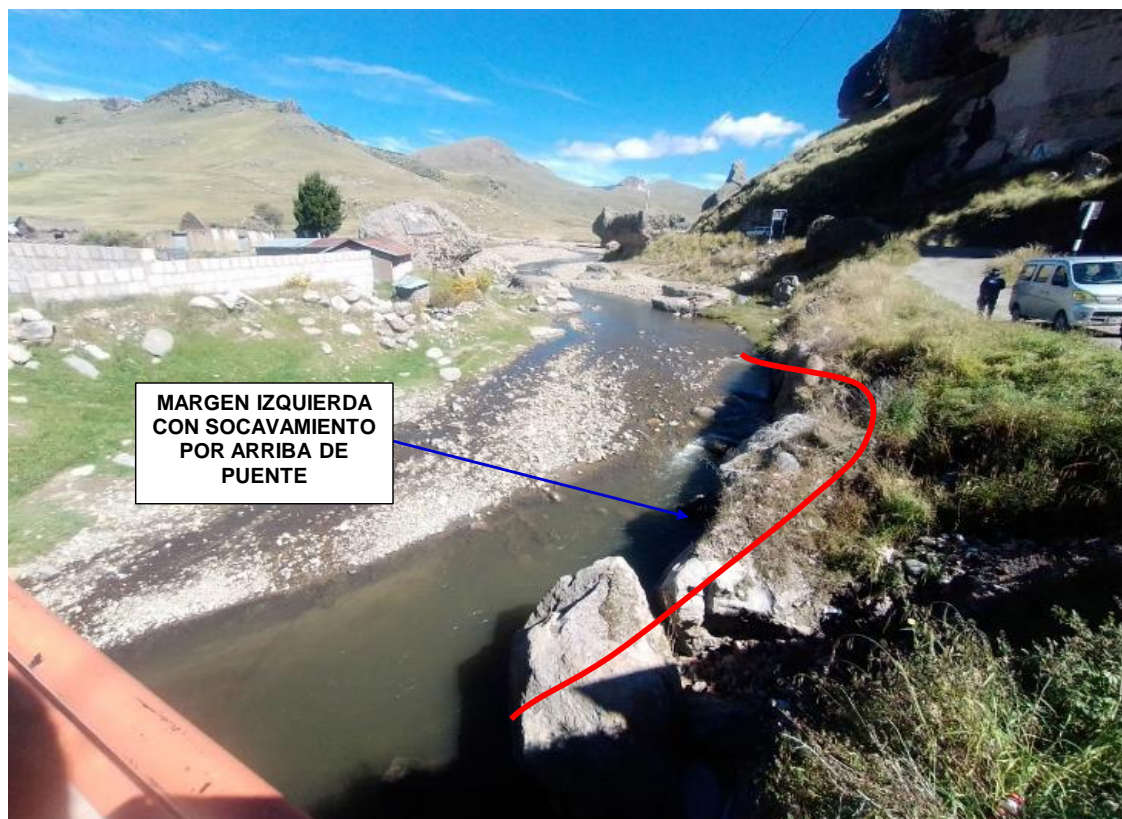
FIGURA N° 02: RIO CHALLAMAYO EXPUESTO ANTE SOCAVAMIENTO POR LA MARGEN IZQUIERDA EN EL PUENTE CARROZABLE DE CENTRO POBLADO.
